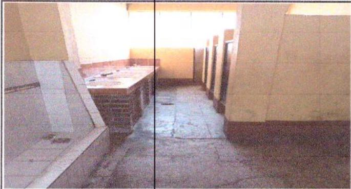
Foto 1: cambio de piso de cemento a piso de ceramica en sanitarios de hombres y mujeres del segundo nivel, y sanitarios los existentes ya estan deteriorados por el tiempo. Alumnos beneficiados 425.
