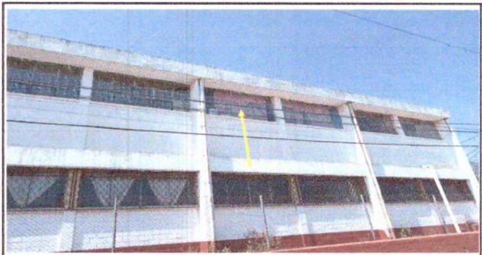
Foto 4: Modificar y Colocar ventanas para que se puedan abrir y obtener ventilación en los salones del segundo nivel, ya que por tener techo de lámina en verano aumenta la temperatura, alumnos veneficiados 285
